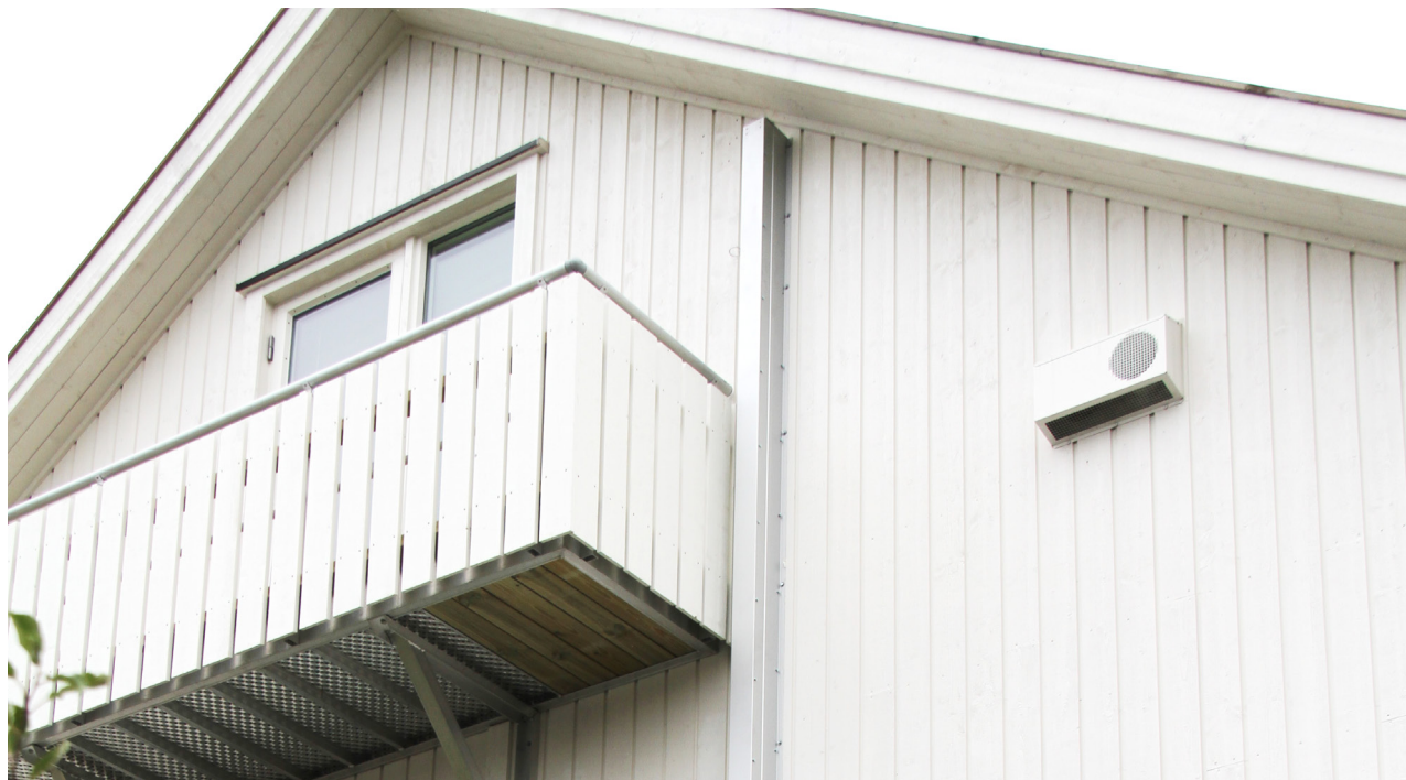
Bøylestigen er en utfellbar stige som er liten og nett på veggen, den måler kun 13*13 cm innslått. Utslått er den 70*70.
